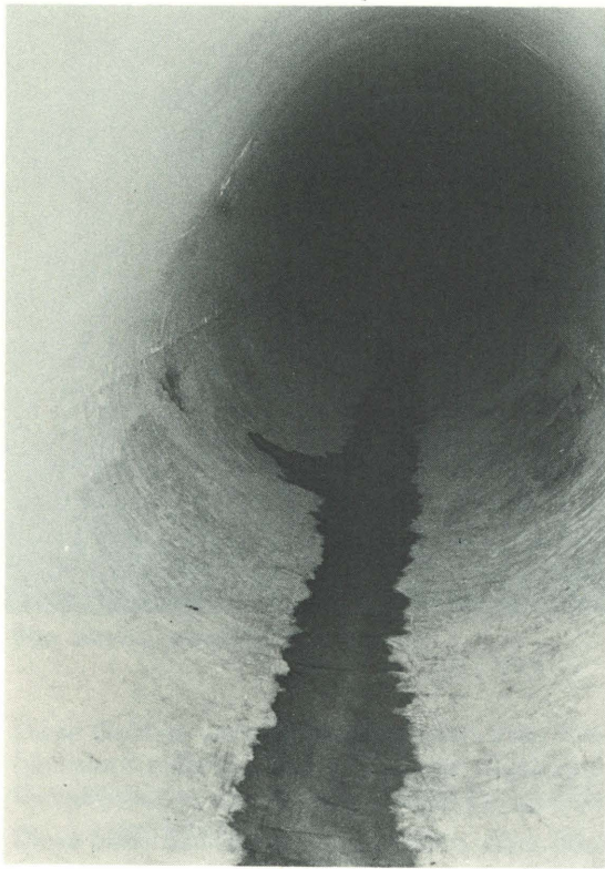
Saniertes Kanalstück
