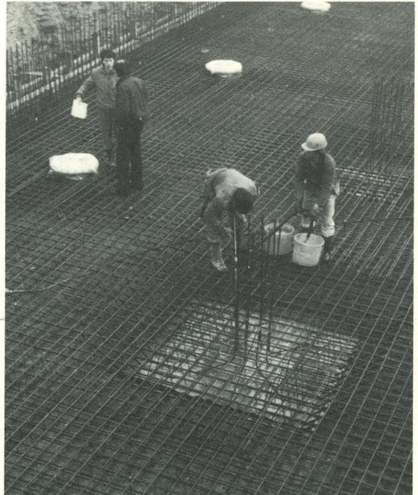
Am 25. April 1986 wurde die Armierung des quadratischen Teils der Bodenplatte des Reservoirs (510 m<sup>2</sup>) abgenommen und betoniert. Dazu waren gut 22 t Armierung, inkl. allen Anschlusseisen, und 165 m<sup>3</sup> Beton erforderlich. Im Vordergrund ist eine Fundamentverstärkung unter einer geplanten Stütze zu erkennen.
