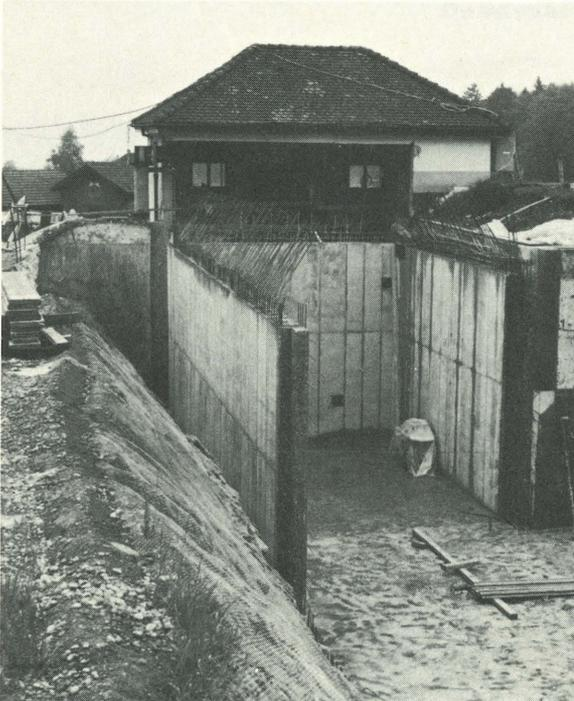
Mitte März 1986 wurde der Bodenplattenteil beim Schieberhaus erstellt und Ende März die Wandetappe 1 als Winkel von 30 bis 50 cm Stärke gegen Schieberhaus und altes Reservoir (rechts im Bild). Mitte Mai wurde die 4. Wandetappe von 35 cm Stärke betoniert (links im Bild). Wandhöhen zwischen 4,35 und 4,85 m.
