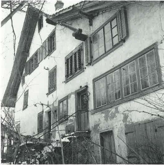
1. Februar 1986: Vor dem Baubeginn.
