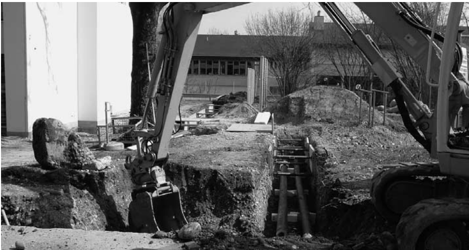
Durch die Schulanlagen müssen kreuz und quer Gräben erstellt werden. (Foto: E. Sonderegger)
